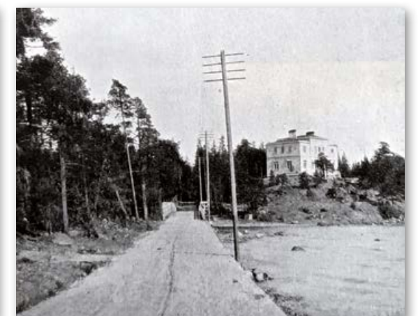
Södra strandvägen - Etelä Rantatie ennen vuotta 1912
